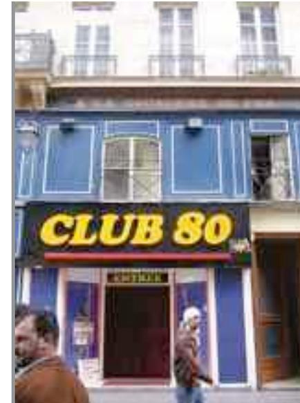
— — — Bandeau et lettrage de hauteurs trop importantes et de traitement visuellement trop prégnant dont l'effet est aggravé par le bleu, à la fois des vitrages occultés et de l'habillage en menuiserie du rez-de-chaussée et de l'entresol
