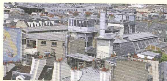
Vue des toitures et des émergences du magasin 4, côté Rivoli
