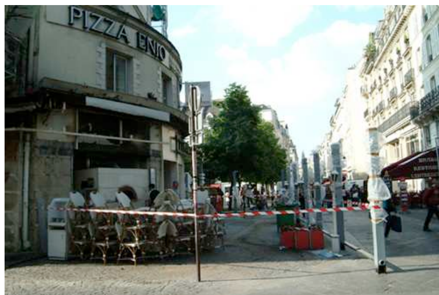
terrasse en construction avec poteaux fixés dans la chaussée le poteau de coin est au milieu de la chaussée (!)
