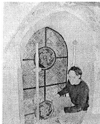
La repose sur site des vitraux
