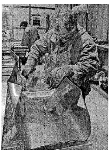
Entretoise en cours de restauration
