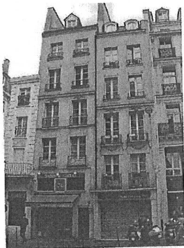
Vue 7 : Immeubles d'habitation du 17 ème siècle au 92 - 94 rue Saint Honoré
