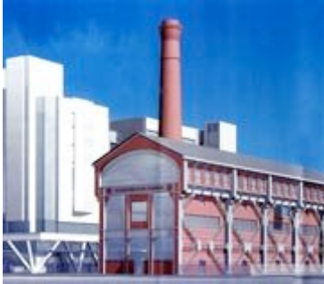
La Société urbaine d'air comprimé (au premier plan), située dans le XIIIe arrondissement, accueillera l'école d'architecture Paris Val-de-Seine. Photo: mairie de paris
