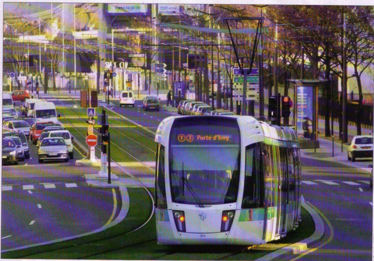
Le tramway des Maréchaux sud. L'ancienne voie ferrée de la petite ceinture n'a pas été utilisée pour le T3. Il a exigé trente mois de travaux.
