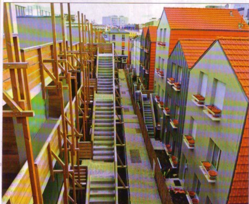
L'îlot de la rue des Vignoles (XX e arrondissement). Dans ce quartier en réhabilitation, 99 logements neufs ont été livrés à l'Opac en 2009.
