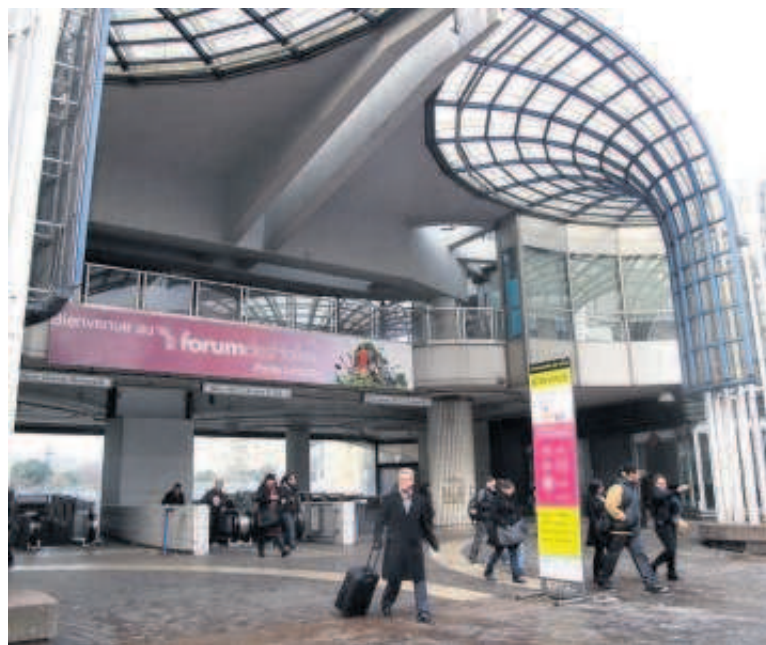
PAVILLONS VILLERVAL (1 er ), MERCREDI. Les quinze commerces installés à l'intérieur auront fermé d'ici à la mi-février pour que les travaux de démolition puissent commencer.
