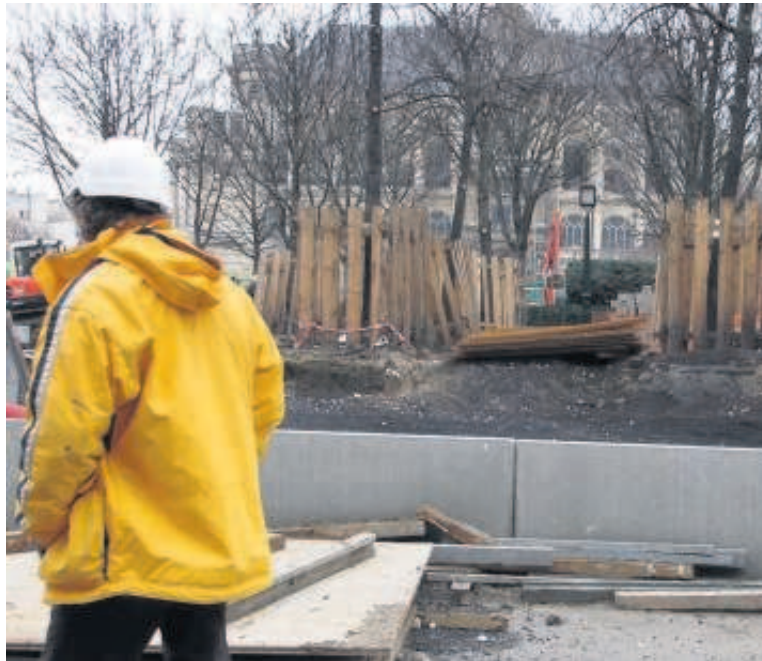
LES HALLES (1 er ), HIER, 11 HEURES. L'immense chantier de transformation des Halles a commencé. (LP/PH.B.)
