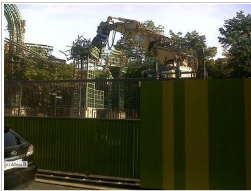
(c) Alexi B. : travaux de démolition à la Porte Berger au Forum des Halles le 13 septembre
