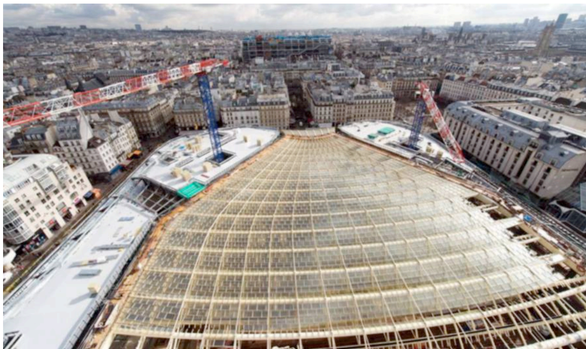
Forum des Halles (1 er ). La Canopée vue du ciel : la verrière jaune étend sa toile sur 2,3 ha. Ecrasante pour certains, étonnante pour d'autres, la structure de 7 000 t d'acier ne laisse pas les passants indifférents. (SemPariSeine/Franck Badaire.)
